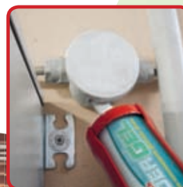
ANSCHLÜSSE IN FEUCHTER UMGEBUNG
