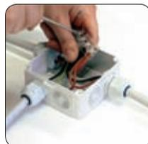
Desfilas los cables y realizar la conexión.
