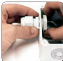
Instalar los sujeta cables.
