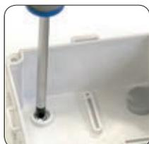
La boîte est fixée à la paroi et les vis sont couvertes à l'aide des bouchons.
