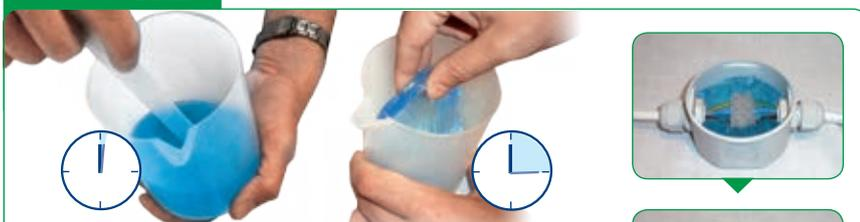
Verser les composants dans la mesurette, mélanger et laisser réticuler (environ 15 minutes). Retirer l'isolant et le placer en petits morceaux autour de la connexion de façon à ce qu'elle ne soit pas complètement recouverte. Naturellement, il est possible d'utiliser l'isolant conservé lors de mélanges précédents.
