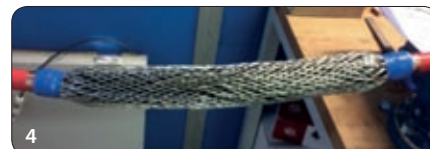
4 Het metalen scherm wordt opnieuw gevormd
