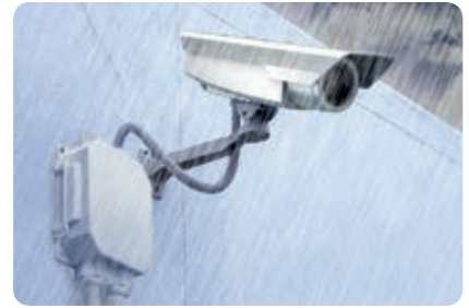
Installatie met vrije kabels
