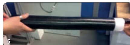
5 De externe beschermhuls wordt aangebracht en gemonteerd
