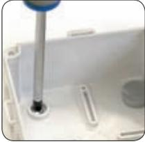
Fixar a caixa à parede e tapar os parafusos com os tapa-parafusos.
