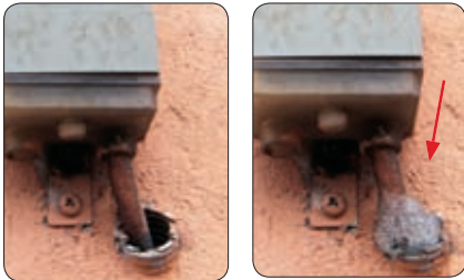
Protecção da entrada do tubo corrugado
