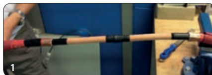
1 Os cabos são preparados e conectados
