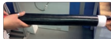
5 A bainha de proteção externa é posicionada e instalada
