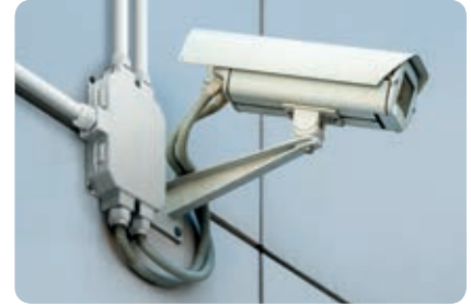
Na parede com cabos
