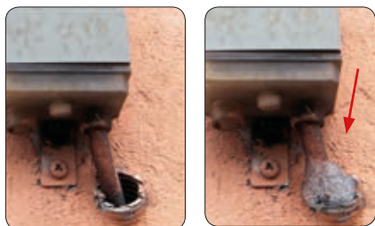
Protecção da entrada do tubo corrugado
