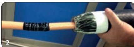
3 A junta é montada no cabo conectado
