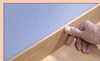
Fissaggio battiscopa
