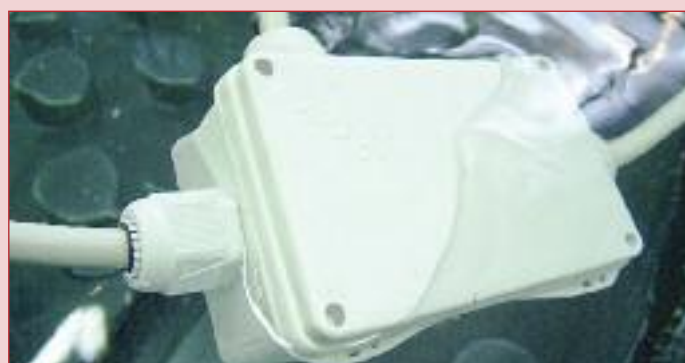
Installation en puits
