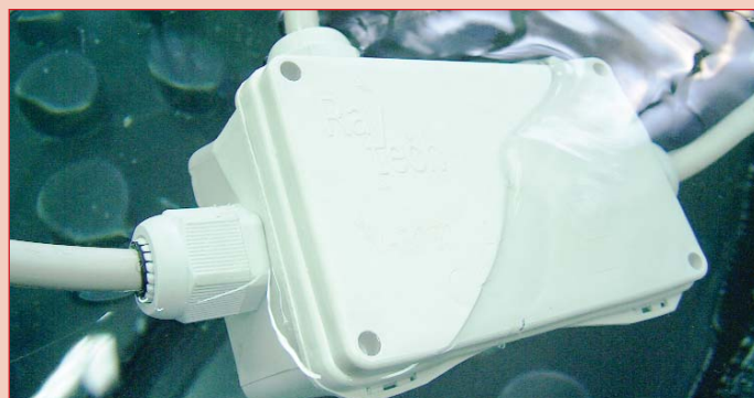
Installazione in pozzetti
