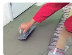
**PRECAUCIÓN:** Al tratarse de un cable de alimentación constante, el cable Easy Floor no puede ser cortado, empalmado o sobrepuesto.
