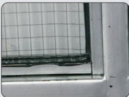
Sealado de vidrios
