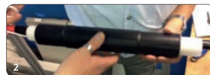
2 La jonction est centrée sur la connexion
