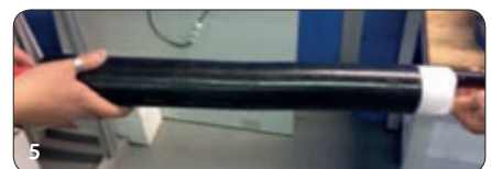
5 On place et installe la gaine extérieure de protection
