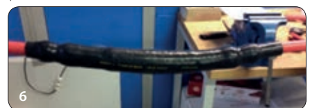
6 La jonction est prêt et peut être immédiatement utilisé
