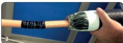
3 De aansluiting is aangebracht op de aangesloten kabel
