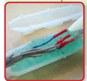
AANSLUITINGEN ONDER WATER
