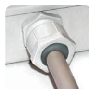
Afdichting van kabelwartels
