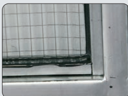
Selagem de vidros
