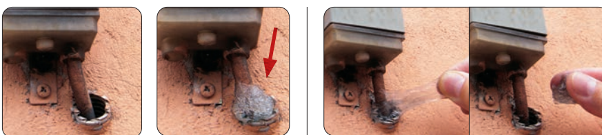
Protecção da entrada do tubo corrugado
