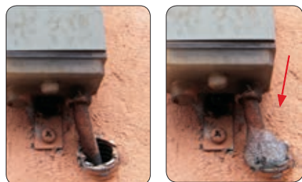
Protecção da entrada do tubo corrugado
