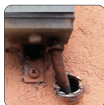
Protecção da entrada do tubo corrugado
