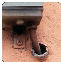
Protecção da entrada do tubo corrugado
