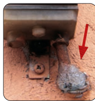
Protecção da entrada do tubo corrugado
